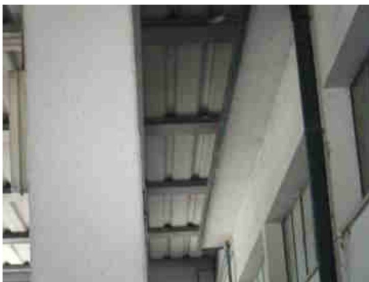
Fig.15 Rimozione dei pannelli di copertura e intradosso
