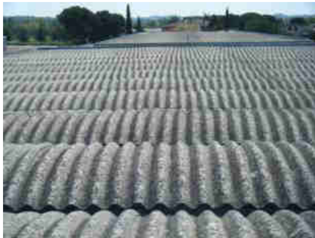
Fig.8 rimozione dei pannelli di copertura
