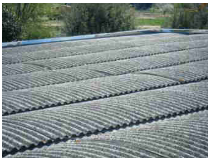
Fig.14 Rimozione dei pannelli di copertura e di intradosso
