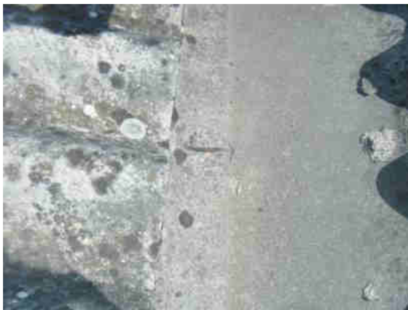
Fig.10 Ripristino del copriferro
