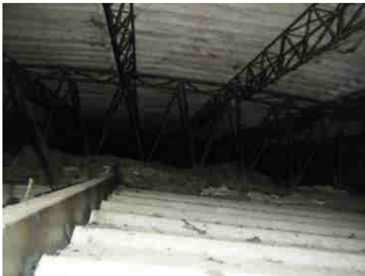
Fig.4 rimozione controsoffitto e pannelli di copertura
