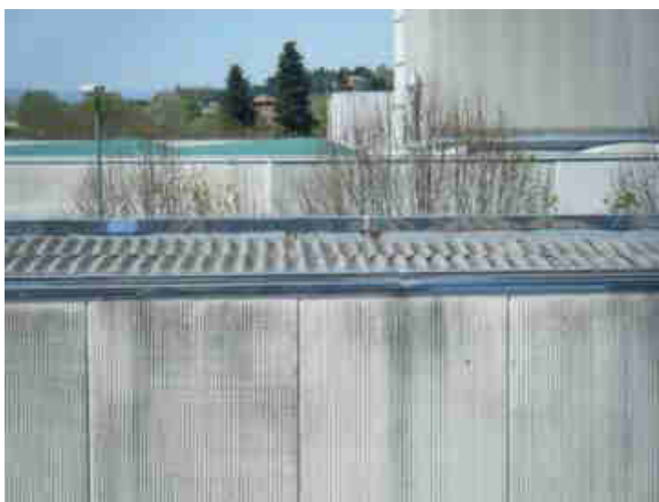
Fig.16 rimozione dei pannelli di copertura e di intradosso
