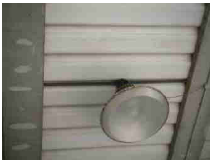
Fig. 13 Rimozione dei punti luce all'intradosso dei due fabbricati
