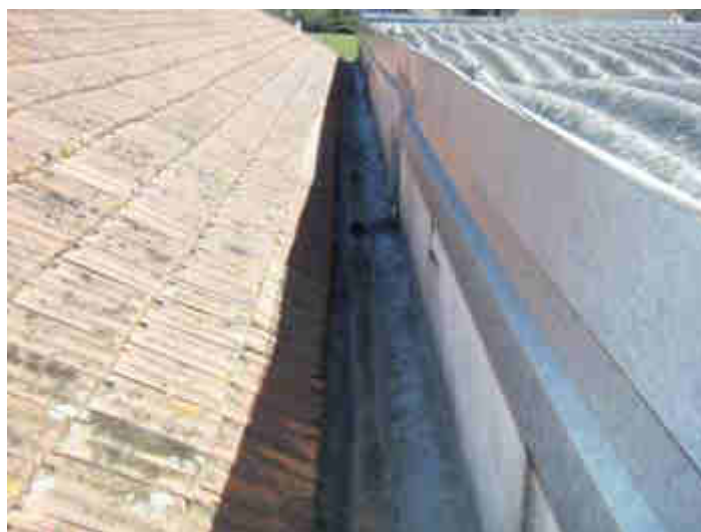
Fig.18 ripristino guaina in adiacenza tra le strutture
